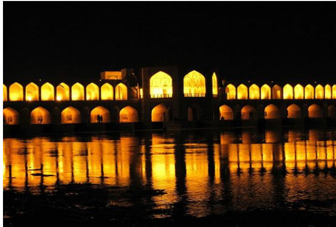
(شکل ۳) نمای پل خواجو در شب.
